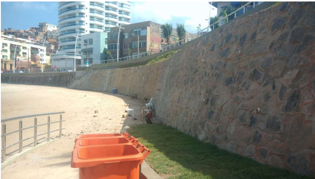
Figura 9: Muro de pedra argamassada
